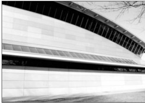
Farbtonunterschiede an der Fassade einer Mehrzweckhalle: Hier wurden Pulverlacke des Farbtons ca. RAL 9006 eingesetzt, die von zwei verschiedenen Lieferanten stammten.
