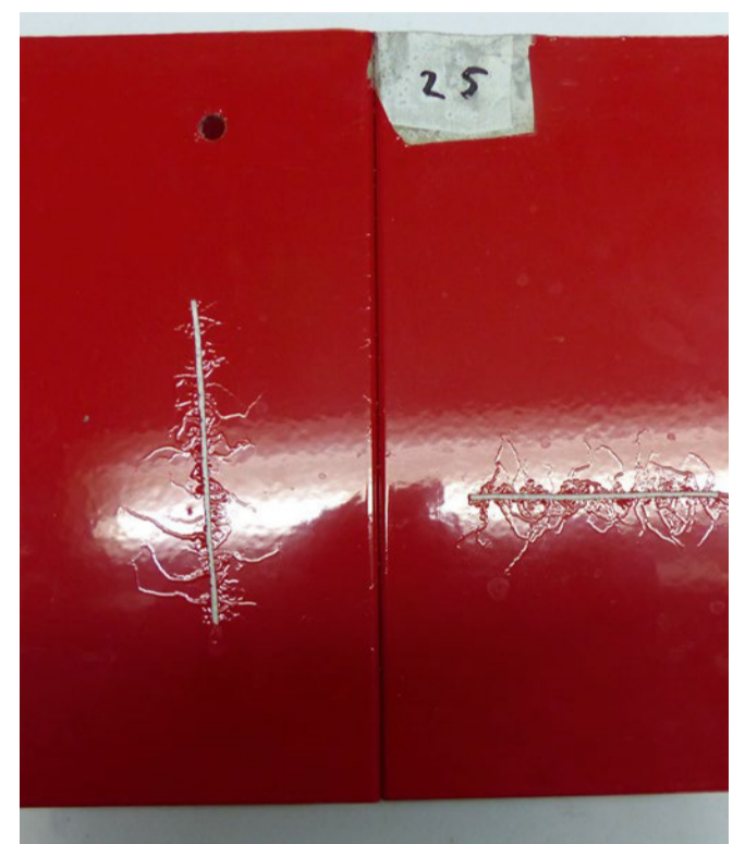
Das pulverbeschichtete Aluminium-Bauteil weist nach dem 1000stündigen Filiformkorrosionstest deutlich erkennbare und fadenförmig verlaufende Korrosionskanäle auf.
